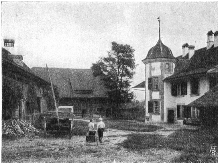
Abb. 14. Gutshof „im Tal“ zu Ittigen (bei Bern). Turmartiger Treppenhausembau an das Bauernhaus, das den Charakter eines Herrschaftssitzes erhält. Aufnahme von E. Pfirter, Bern. — Fig. 14. Maison d'habitation à Ittigen. Une tour d'escalier a été ajoutée à la maison paysanne.
