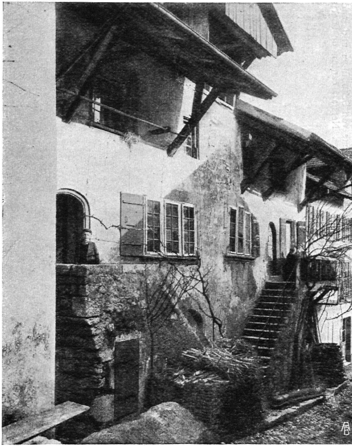
Abb. 9. Steinbauten in Twann, mit weiten, dem Holzbau entstammenden Dachausladungen. Besondere Ausbildung der Traufe und des Estrichloches. Aufnahme von R. Minder, Biel. — Maisons en pierres à Douanne. Les avant-toits, très larges, sont un souvenir des anciennes constructions en bois. Remarquer le développement qu'ont pris les gouttières et les combles.
