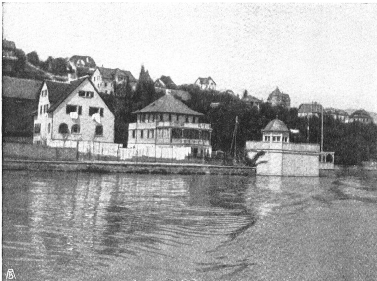
Abb. 23. Nutzbau bei Kilchberg am Zürichsee, der in Form und Farbe das Uferbild verunziert. Aufnahme von Dr. H. Peter, Zürich. — Fig 23. Petite construction près Kilchberg, lac de Zurich, qui jure désagréablement par ses formes et ses couleurs avec le paysage ambiant.
