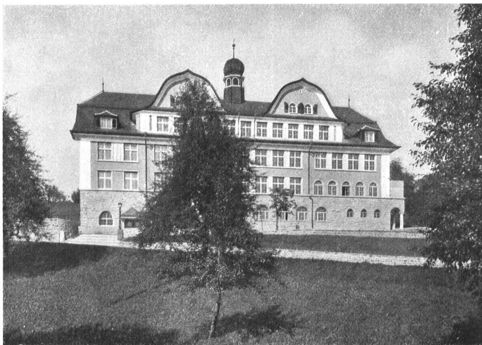
Abb. 13. Schulhaus in Ruswil. Das Dach mit den Giebeln und dem Dachreiter wirkt überzeugend als zusammenfassender, praktisch und künstlerisch wertvoller Bauteil. Architekten B. S. A. Möri & Krebs, Luzern. — Fig. 13. Maison d'école à Ruswil. Le toit avec ses pignons et son petit clocher constitue un des principaux éléments artistiques du bâtiment. Tout en remplissant son but pratique, il donne à l'ensemble son caractère et son unité.
