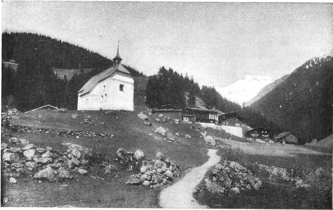
Abb.9. Kirchli in Accletta oberhalb Disentis. Das Gotteshaus ist als Steinbaute vor der Umgebung ausgezeichnet. Aufnahme von Ingenieur F.Meyer , Disentis. – Fig.9. Chapelle à Accletta, au-dessus de Disentis. Cette construction en pierre frappe au milieu de son entourage.
