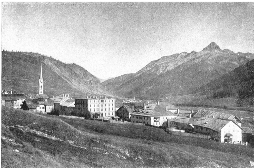
Abb. 13. Dorfansicht; der Hotelbau mit seinem platten Dach, im Vordergrund, bedeutet einen Missklang im Gesamtbilde. — Fig. 13. Vue de Zuoz. Au premier plan, un hôtel au toit plat et aux formes anguleuses jette une note discordante dans ce pittoresque paysage.
