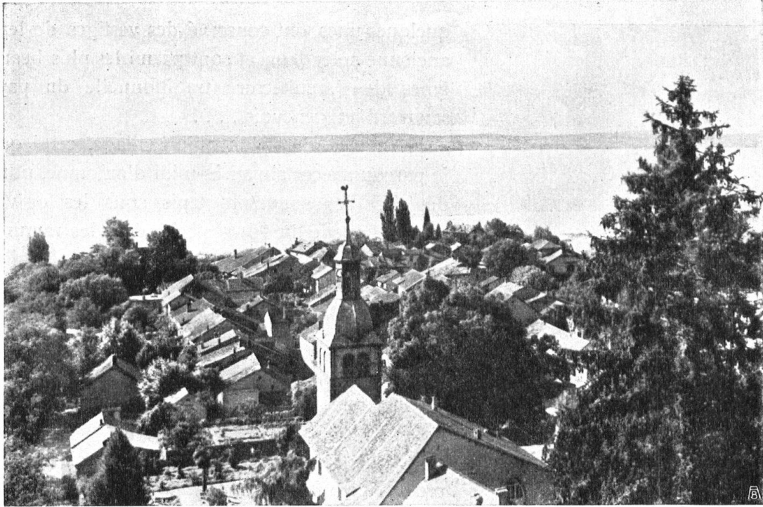
Fig. 4. Vue du Bourg-dessous, prise du sommet de la tour. Cliché F. Boissonnas , Genève. — Abb. 4. Blick auf den unteren Teil des Städtchens, vom Turm aus aufgenommen. Photographie von F. Boissonnas , Genf.
