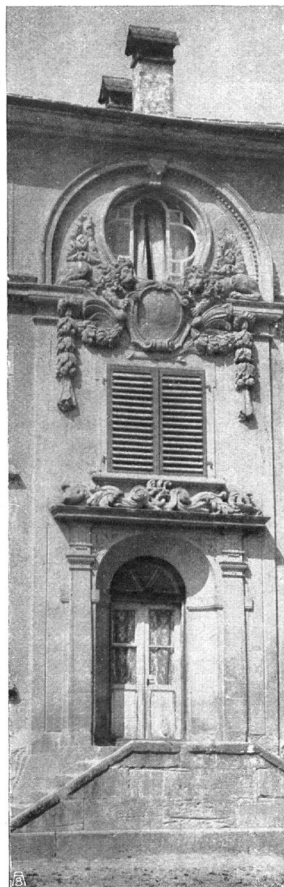
Von der ehemaligen Universität in Bern, jetzt abgetragen Partie de la façade de l'ancienne Université de Berne, maintenant démolie
