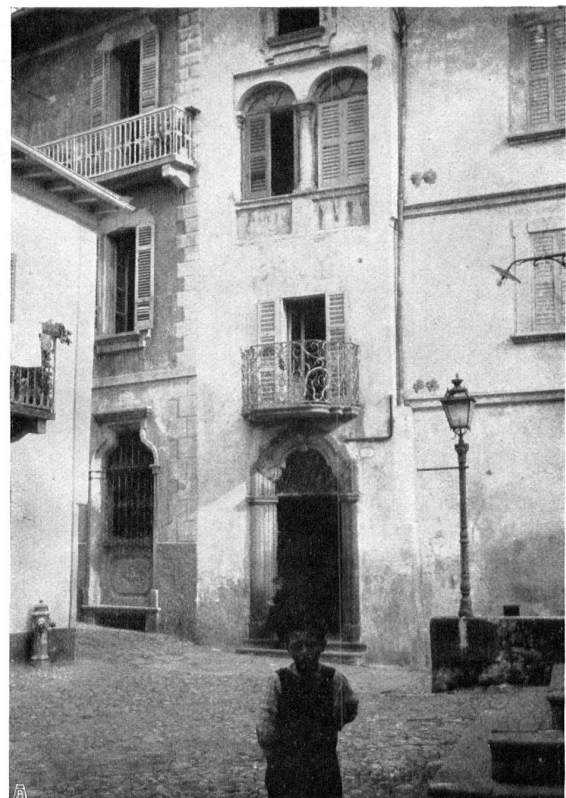
VON EINEM HAUSE IN BRISSAGO UNE ENTRÉE A BRISSAGO
