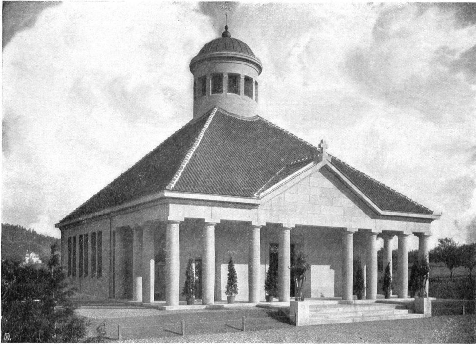
FRIEDHOFKAPELLE AUF DEM FRIEDHOF ZUR KESSELHALDE DER GEMEINDE TABLAT (St. Gallen), für beide Konfessionen bestimmt. Ernster Bau in zweckentsprechender Stimmungsvoller Formgebung. Erbaut 1908/1909 von Architekt B. S. A. A. Cattal , St. Gallen CHAPELLE DU CIMETIERE DE LA COMMUNE DE TABLAT (St-Gall) affectée aux deux religions. Construction de style sévère, qui indique bien clairement la destination de la chapelle. Bâtie en 1908/1909. Architecte A. Cattal , St-Gall (membre de la «B. S. A.»)
