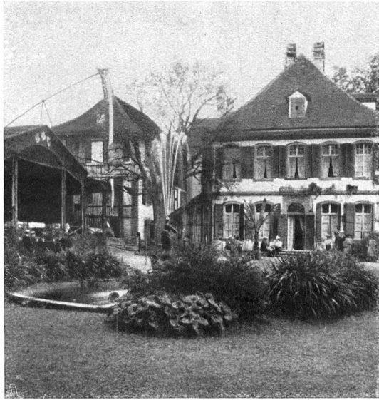
Blick in den Garten. Im Hintergrund die Südfront des Hauses mit dem fatalen Anbau nach Westen. Links die alles verderbende Trink- halle mit Flagge Vue du jardin. Face sud de la maison; à gauche une malheureuse buvette avec oriflamme
