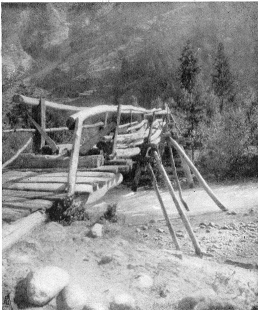
ALTE BRÜCKE BEI SAAS-GRUND. Letztes Beispiel der für dieses Tal charakteristischen Brückenbauten VIEUX PONT SITUÉ NON LOIN DE SAAS-GRUND. Ce pont est un des derniers représentants de ce spécimen particulier à la vallée de Saas
