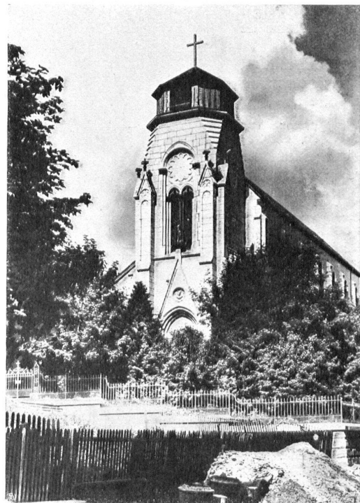
L'ÉGLISE CATHOLIQUE DE ST-IMIER. La tour qu'on projette de surmonter d'une flèche, ne pourra que perdre à ce changement. DIE KATHOLISCHE KIRCHE IN SANKT IMMER soll nächstens durch einen hohen spitzen Turmhelm ergänzt und verschönert werden. Die kräftige geschlossene Wirkung dürfte dadurch nur verlieren.
