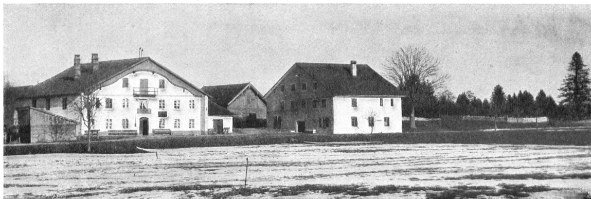
RESTAURANT A LA CHAUX-D'ABEL; l'architecture sobre et de bon goût se rapproche du type neuchâtelois ————— Phot. J. Arn , St-Imier GASTHAUS IN CHAUX-D'ABEL. Deutliche Anklänge an das Neuenburger Bauernhaus —————
