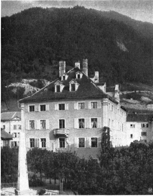
BEISPIEL. DAS REGIERUNGSGEBÄUDE IN CHUR, schlicht vornehm und bodenständig BON EXEMPLE. LA MAISON DU GOUVERNEMENT A COIRE, d'une noble simplicité
