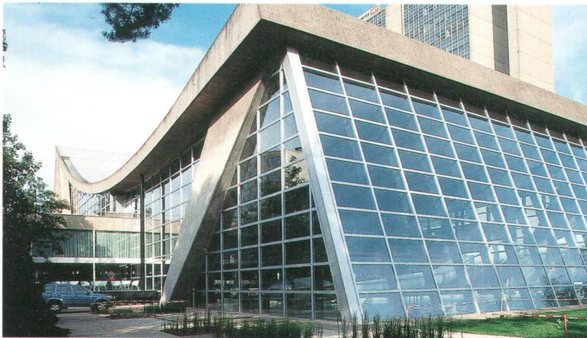
Das grosse Schwebedach wird durch schräg gestellte Pfeiler hochgestemmt. Darunter wirken die weiten Glasflächen fein und leicht (Bild M. Hanak)
