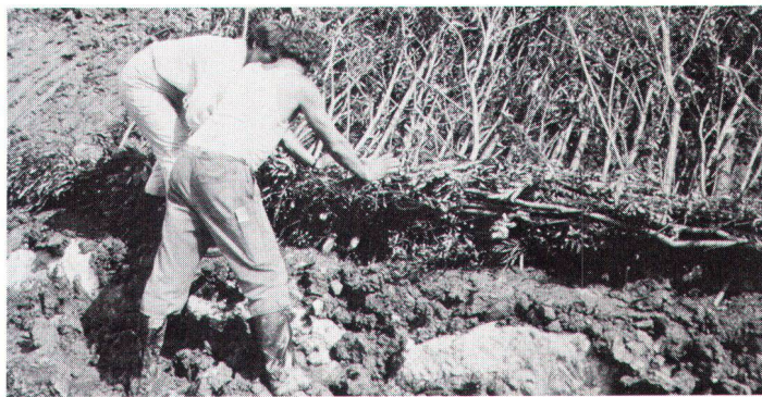
Quand l'ingénieur stabilise les rives avec des matériaux naturels (fascines de saule).
