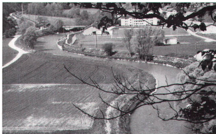
Ein gewundener Lauf entspricht dem Wasser mehr als eine Begradigung: hier die Birs-Korrektion in Liesberg (Bild Zeh).
