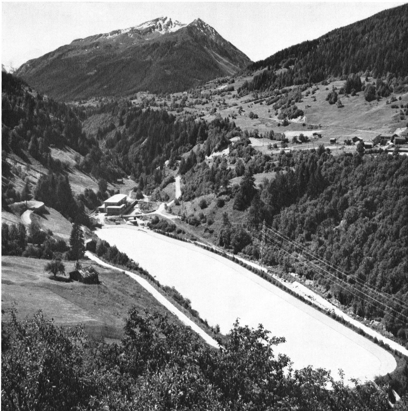
*Les bassins de compensation (ici, celui de Vissoie, dans le val d'Anniviers) sont indispensables dans une installation hydro-électrique à plusieurs étages; car leur eau est nécessaire aux heures de pointe. Du point de vue du paysage, on ne peut que déplorer les constructions qui abritent les vannes, généralement situées au fond d'une vallée.*
