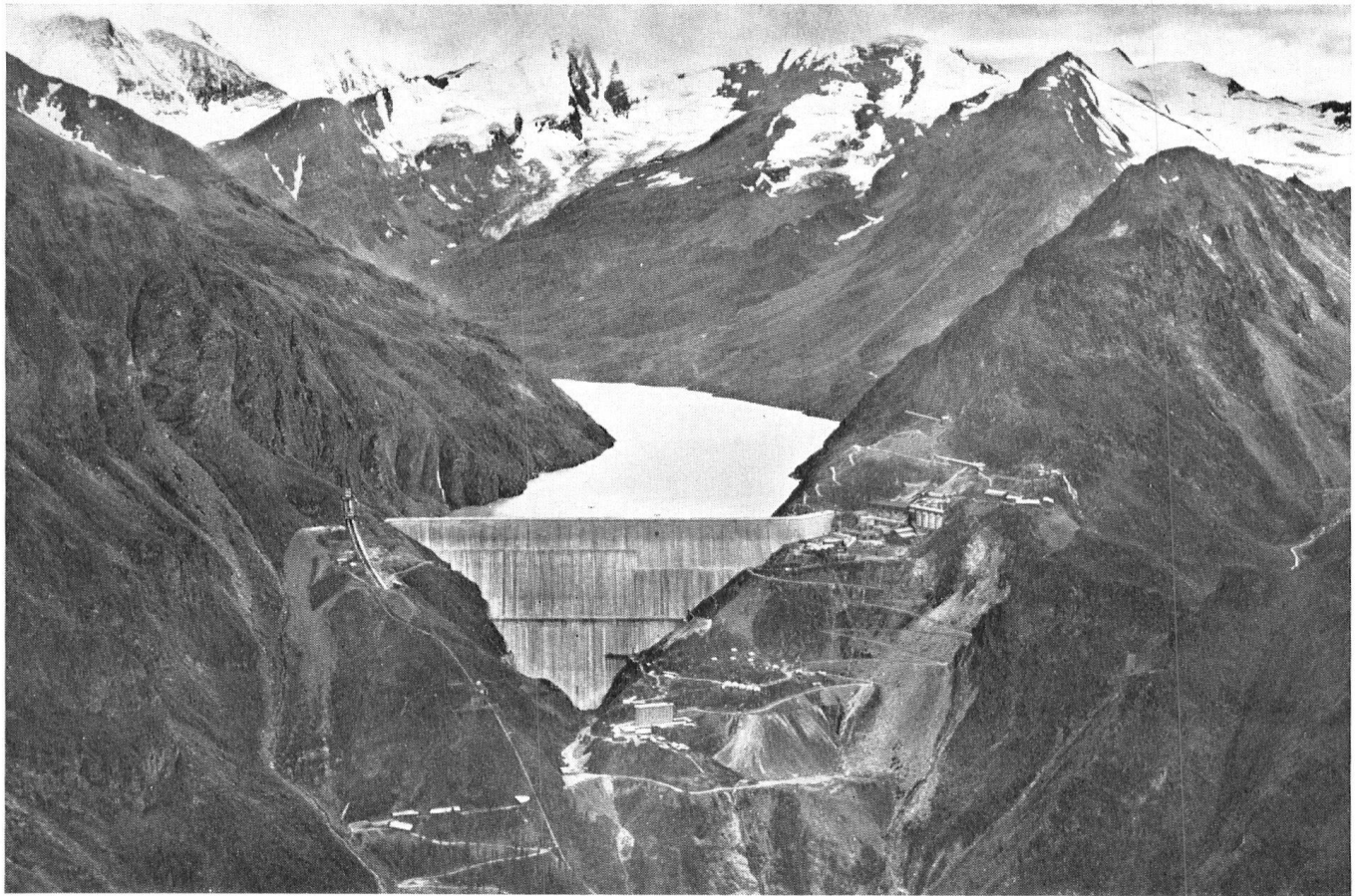
La Grande-Dixence VS, un des plus importants lacs d'accumulation des Alpes. Muraille de béton haute de 284 mètres; longueur du lac 5 km; contenance 400 millions de mètres cubes. Voir dans A. Beerli, « La Suisse inconnue, Valais », édition, page 158, la belle description de ce barrage.
