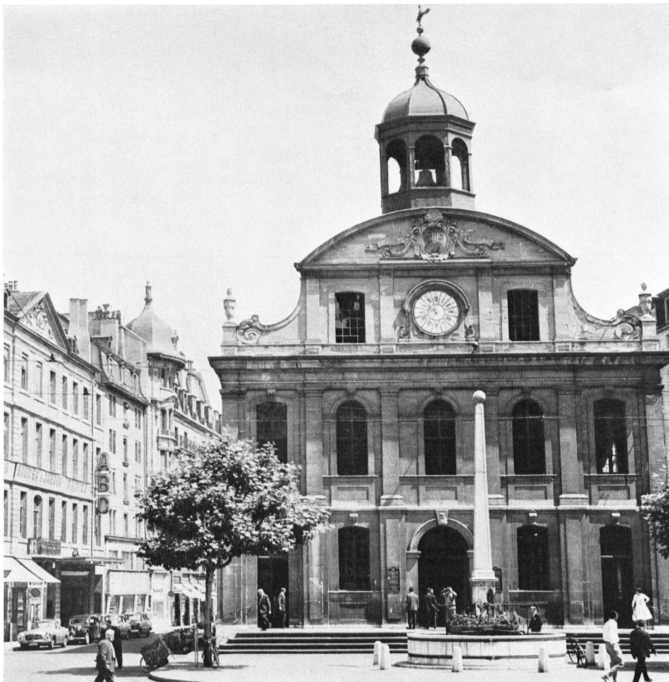
L'église de la Fusterie (1715), bon spécimen de l'architecture sacrée d'inspiration protestante à l'époque baroque. La molasse, matériau usuel alors, est terriblement rongée; la restauration est urgente.
