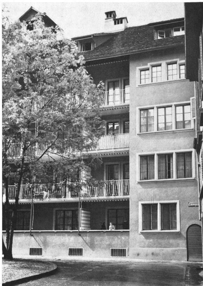
Ein Wohnhaus-Neubau in der Zürcher Altstadt. Links die Nordseite am Rindermarkt, rechts die Südseite an der sonnigen Leuengasse. Die kleinen gotischen Bogenfenster (links) und das gestaffelte Viererfenster (rechts) sind alte Originalstücke der zwei hier abgebrochenen, sehr baufälligen Häuser. 1954.
