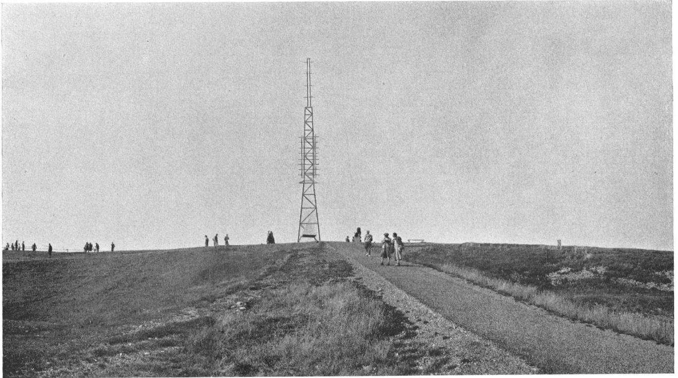
*Der gesäuberte Rigiipfel mit dem eingezeichneten, 27 m hohen Ultrakurzwellen- und Fernseh-Sendeturm. Die Skizze ist nur maßgebend für die Höhe, nicht aber für die Gestaltung des Mastes. Nach Angabe der PTT könnte auch ein abgespannter Mast oder eine Rohrkonstruktion in Betracht gezogen werden.*
