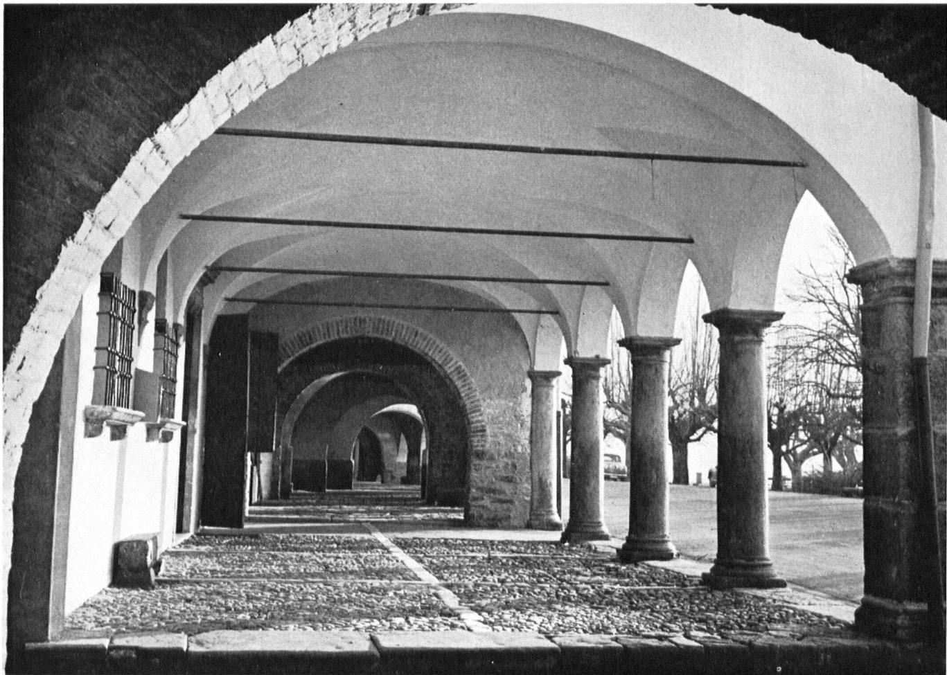
reihen zeigen sich aber noch zwei Füllungsbögen in ganz verschiedener Höhe; es müssen also die Fußböden seit 1300 mindestens zweimal verlegt worden sein. Auch der Dachstock ist etwas erhöht worden – die Löcher der alten Sparren berichten davon. Die Mauern könnten die Geschichte verraten, wenn man diese Mauern innen und außen bloßlegen dürfte.
