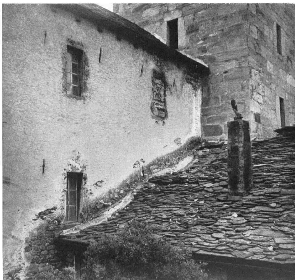
La toiture couverte de schiste valaisan s'affaisse lentement...
