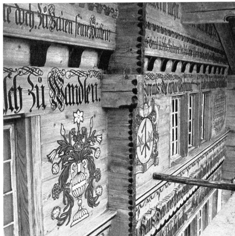
Teilbild der erneuerten Hauswand.
