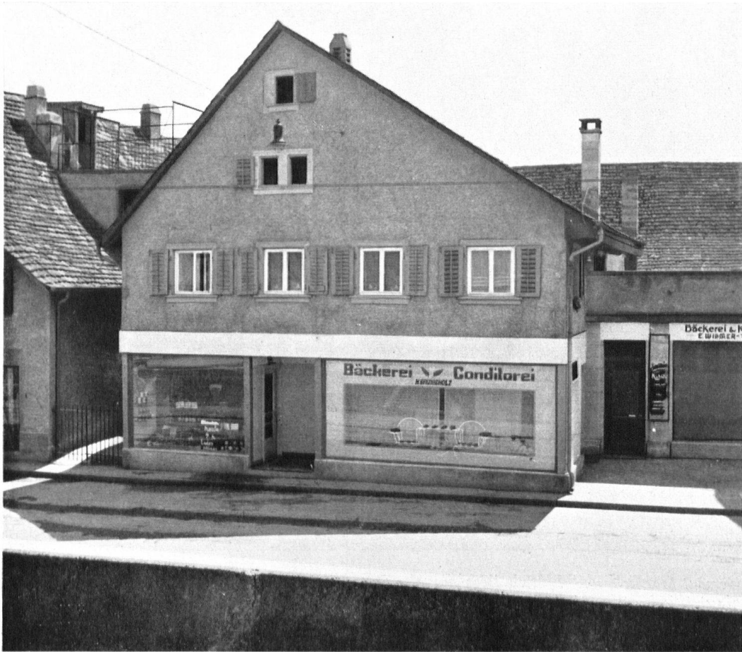
Allschwil. Brutaler Umbau eines einst bäuerlichen Riegelhauses an der Dorfstraße. Ein Gegenbeispiel, das man sich auch anderwärts zur Warnung und Abschreckung merken sollte!
