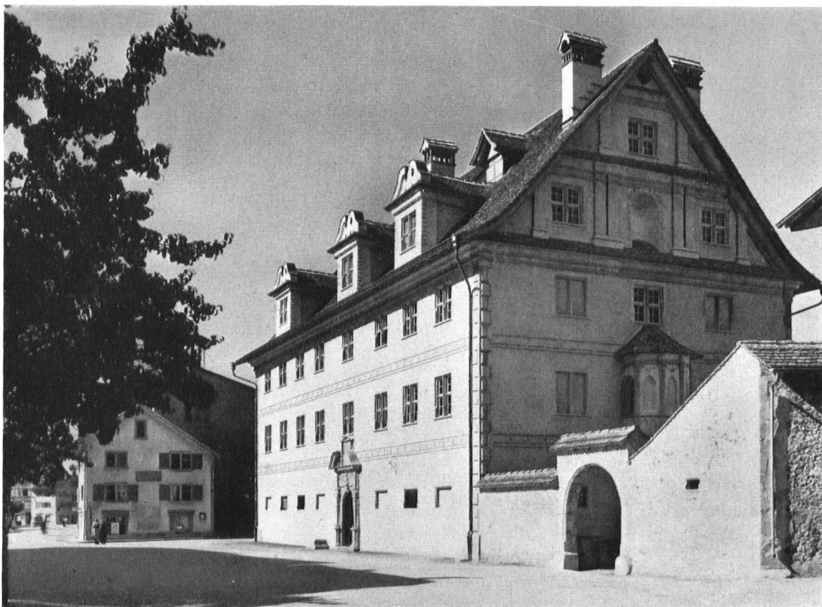
Der Freuler-Palast zu Näfels nach Wiederherstellung der Hofeinfahrt und Abbruch einer hässlichen Ladeneinbaute in der Umfassungsmauer (rechts).
