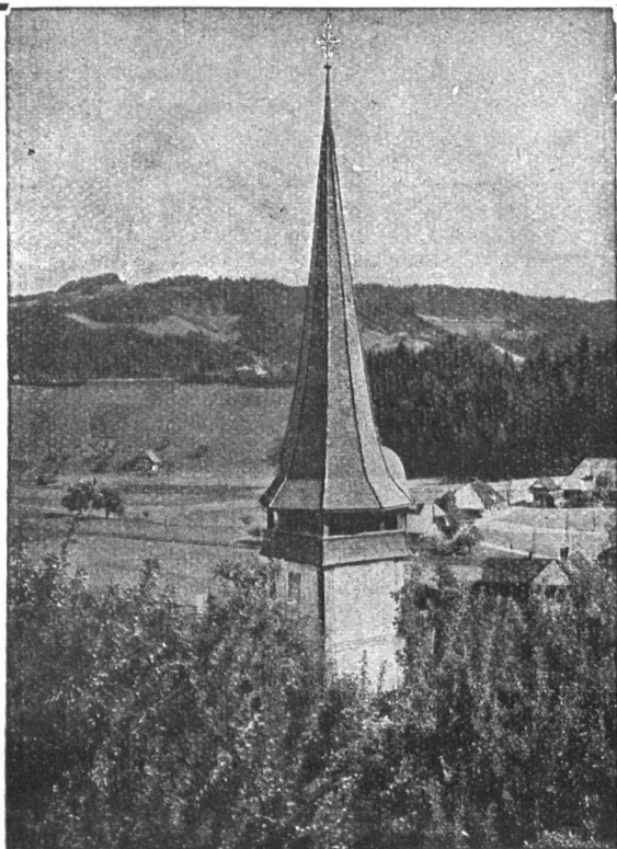
Kirchturm in Signau ETERNIT-DOPPELDACH, KUPFERBRAUN ETERNIT NIEDERURNEN
