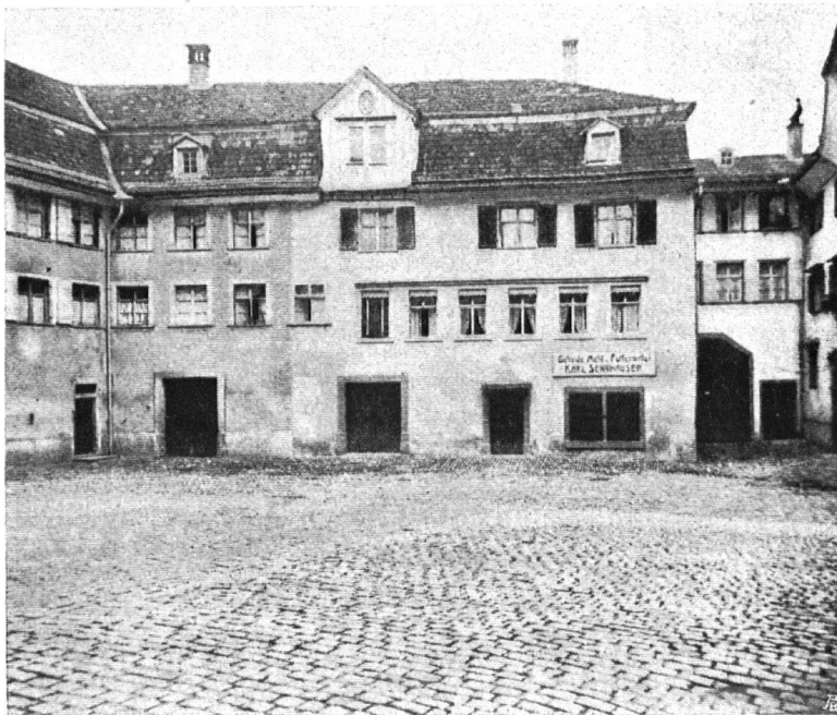
Abb. 7. Der „Goldene Boden“, ein Sammelpunkt des alten Marktverkehrs, ist ein ausgezeichnetes Beispiel für einen mit bescheidenen Mitteln gebildeten Platz. — Fig. 7. Der „Goldene Boden“. L'ancienne place du marché. Modèle d'architecture pour une place de modeste étendue.
