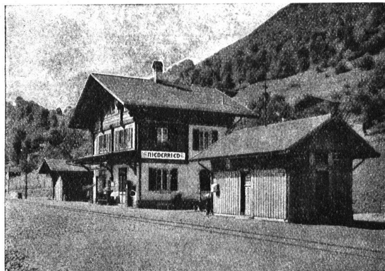
Station der Brienerseebahn. Eternit-Doppeldach, kupferbraun
