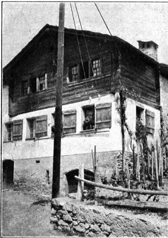
Abb. 7. Der Lichtmast steht zu nahe am Bauernhaus. — Fig. 7. Le poteau est placé trop près de la maison.
