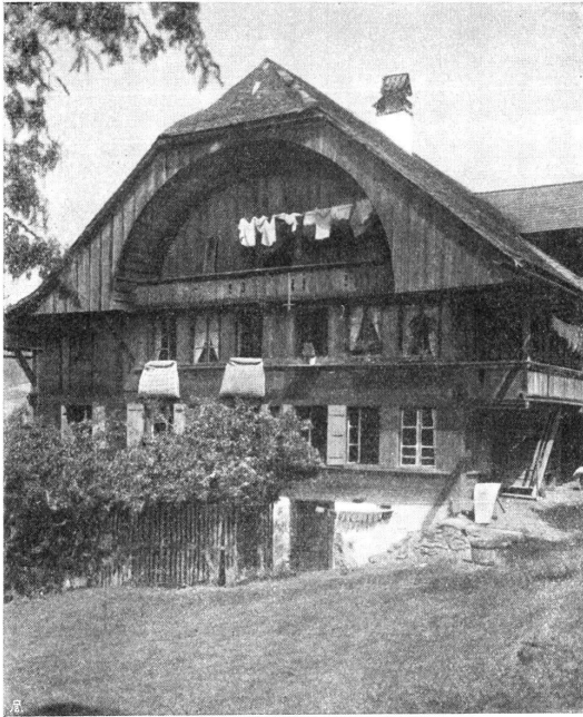
Abb. 7. Heiligenschwendi. Ständerbau. Fig. 7. Heiligenschwendi. Murs de poutres verticales.
