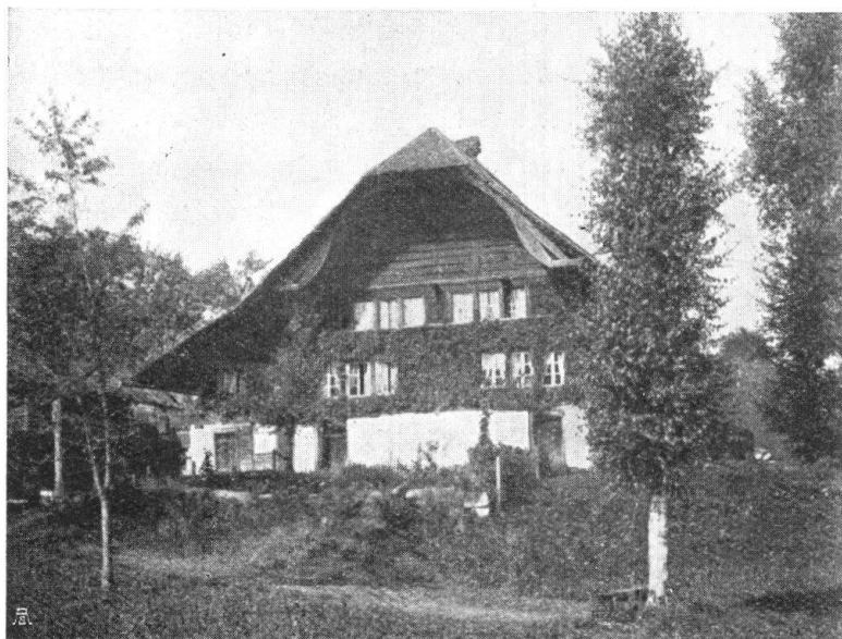
Abb. 12. Bühl bei Amsoldingen. Ständerbau mit sichtbarer Konstruktion des bogenförmigen Giebels. — Fig. 12. Bühl, près Amsoldingen. Murs faits de poutres horizontales. Pignon découvert.
