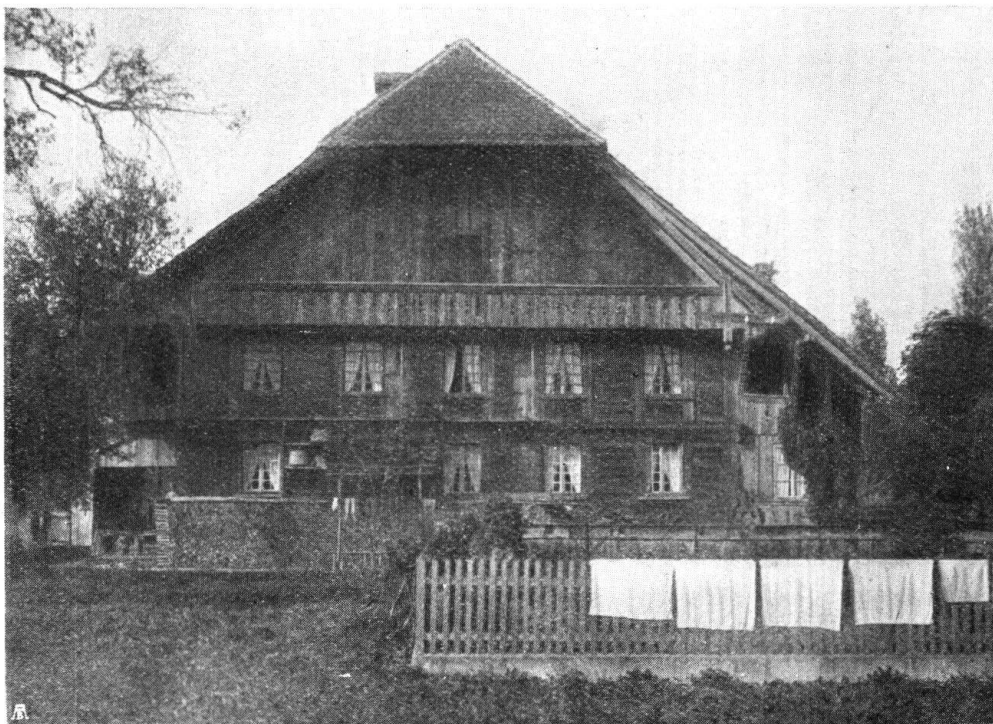
Abb. 6. Allmendingen, Grosses Bauernhaus mit Ständerwand. Fig. 6. Allmendingen, Grande maison paysanne à murs de poutres verticales.
