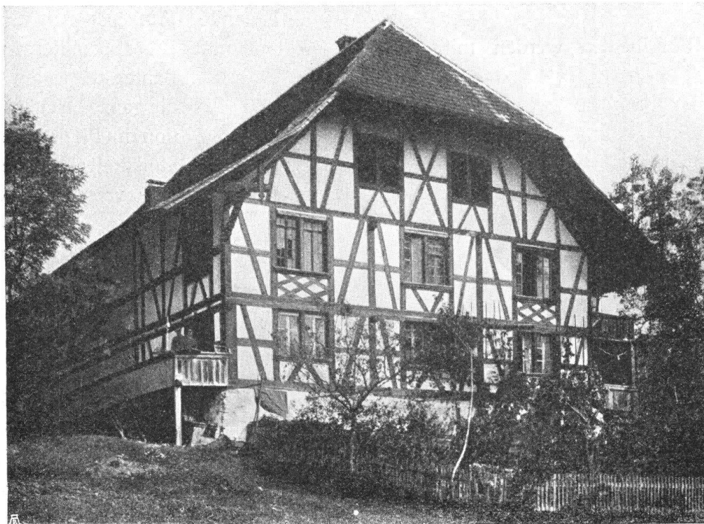
Abb. 15. Seftigen. Fachwerkhaus. Die reichere Ausbildung der Fensterbrüstungen ist in dieser Gegend selten. — Fig. 15. Seftigen. Construction en pans de bois. La riche ornementation des allèges des fenêtres est peu commune dans le pays.
