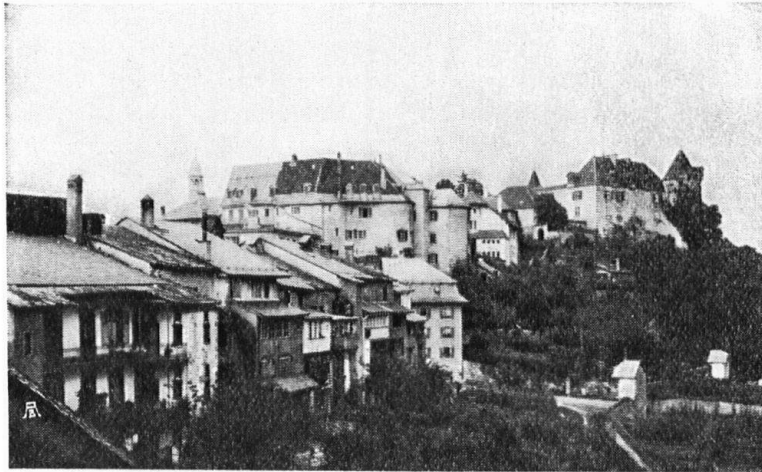
Fig. 5. Gruyères, vue du sud-ouest. Photographie prise des jardins de l'hôtel de la Fleur de Lys. Cliché Konrad Escher, Bâle. — Abb. 5. Gruyères von Südwesten. Aufgenommen aus dem Garten des Hotel Fleur de Lys.
