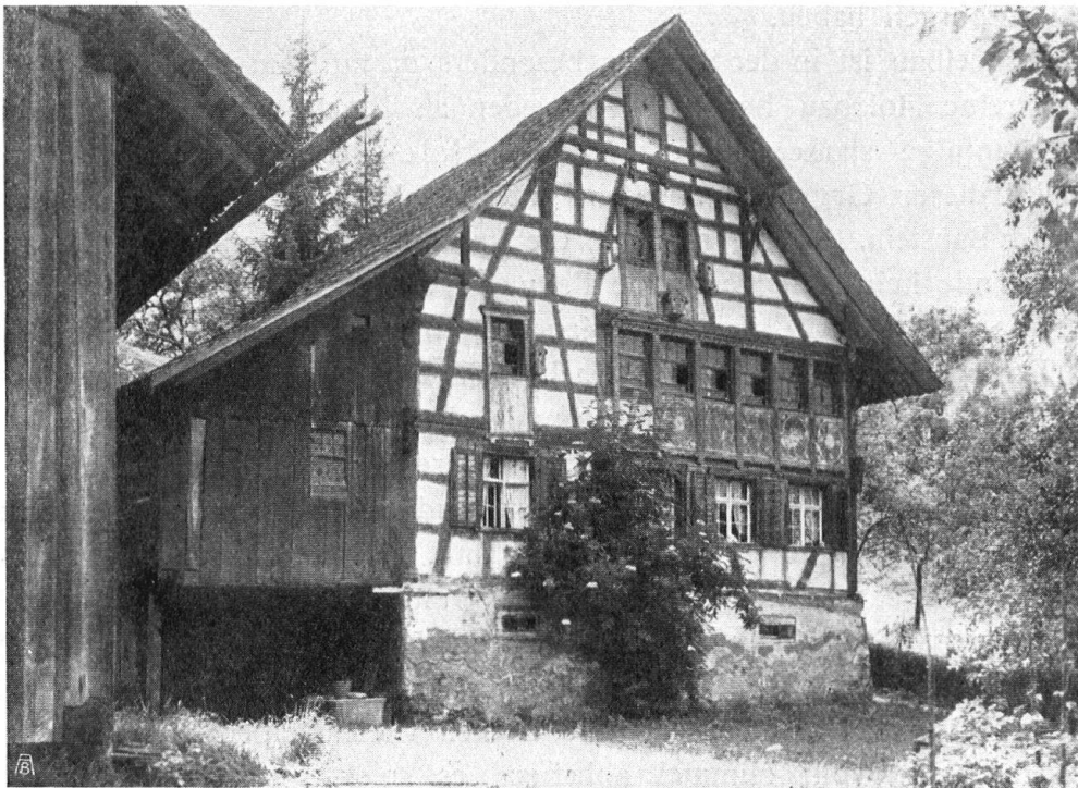
Abb. 5. Thurgauer Bauernhaus im Tobel. Farbige behandelte Zugladen der Reihenfenster. Aufnahme von Hausmann in Heiden. – Fig. 5. Ferme thurgovienne, à Tobel. Les contrevents à coulisse des fenêtres sont décorés de peintures. Cliché Hausmann, Heiden.
