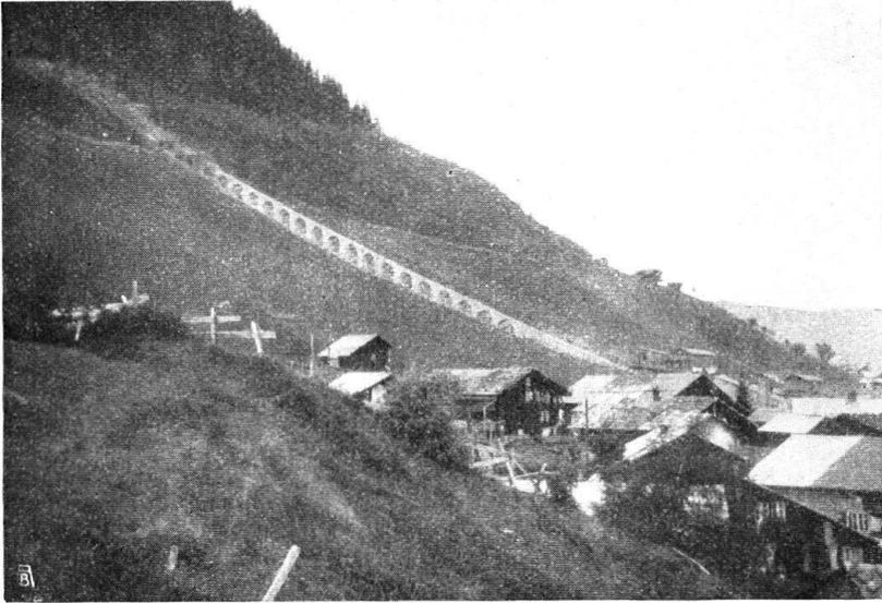
Abb. 6. Im Bau begriffene Drahtseilbahn für Wintersport in Mürren. Der hochgelegte Bahnkörper durchschneidet die Landschaft in hässlicher Weise. Aufnahme von Fr. Rath, Basel. — Fig. 6. Un funiculaire en construction, destiné aux sports d'hiver, à Mürren. Cette ligne surélevée coupe le paysage de la façon la plus désagréable. Cliché Fr. Rath, Bâle.
