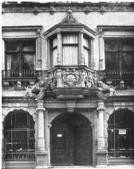
Portal am Hause zum Sittich. Die alte vornehme Einfachheit ist einem Umbau und modernen Zutaten geopfert! – La même façade, dont l'harmonieuse sim- plicité a été sacrifiée à des constructions de goût moderne.
