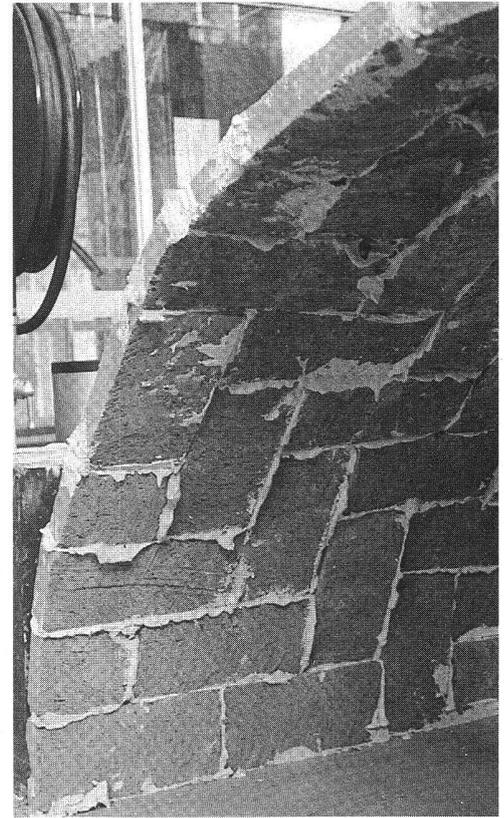
*Voûte réalisée selon un appareillage traditionnel tunisien permettant la suppression du coffrage.*
