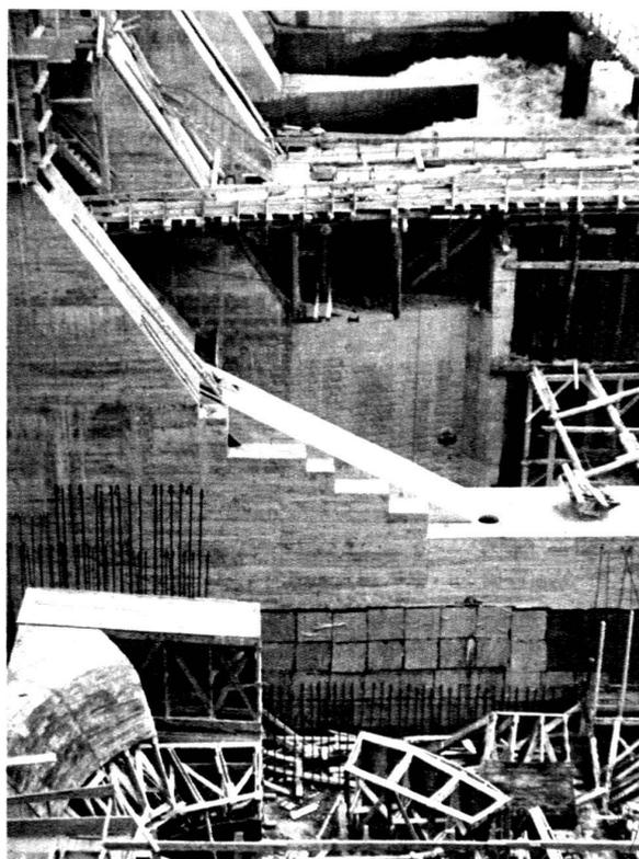
La vue à droite au milieu montre au fond les passes I, II, III et IV du barrage. La travée IV n'est pas encore terminée tandis que le Rhône s'écoule déjà par les autres. Au premier plan, le groupe 4 de l'usine est commencé. (Juin 1942.)
