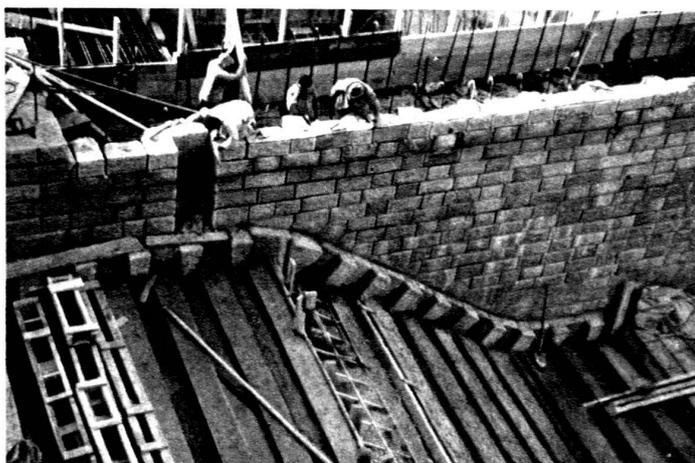
La dernière travée IV du barrage est en terminaison. Des revêtements en granit protègent le béton contre l'usure des sables et graviers qu'entraînent les flots du Rhône en temps de crues.
