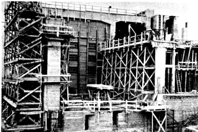
Ci-dessous, une vue des échafaudages nécessaires pour la construction du mur aval de l'usine, à l'endroit des groupes 3 et 4. (Juin 1942.)
