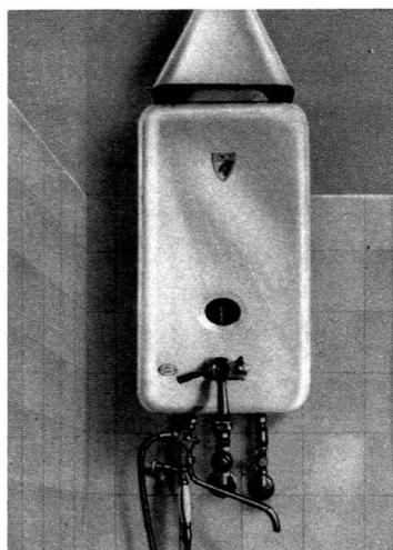
**Chauffe-bain à gaz** moderne, modèle fermé à mise en marche simplifiée. Aucune fausse manœuvre possible en allumant la veilleuse et en mettant l'appareil en fonction. Nouvelle robinetterie évitant tout allumage brusque.
