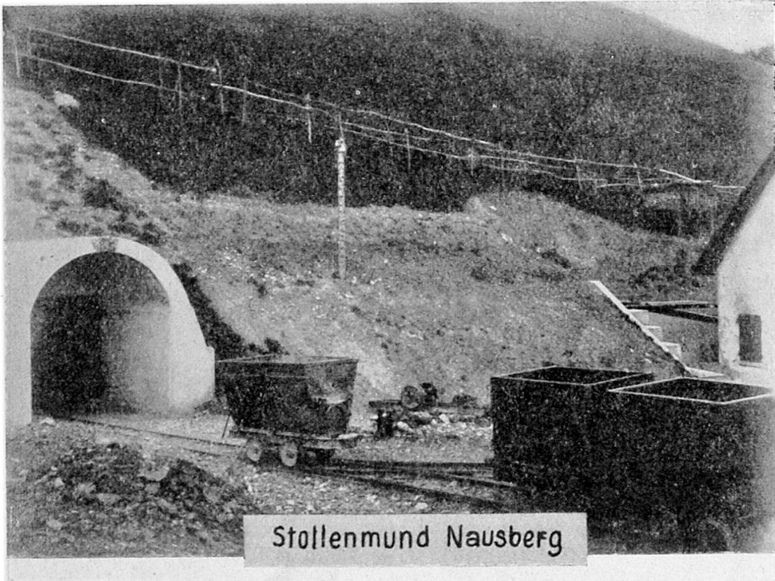
Abb. 7. (Jetzt durch einen gedeckten Schienengang mit der Erzseilbahn verbunden).
