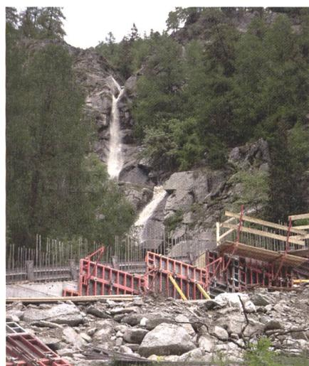
Abb. 1: Bau eines neuen Geschiebeablageplatzes in St. Niklaus.
