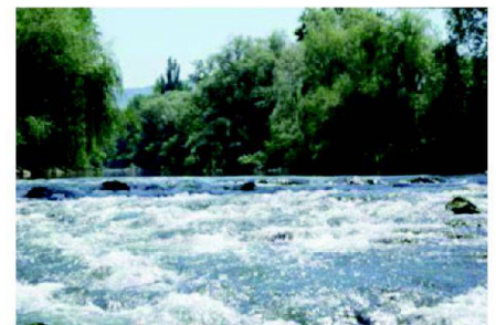
Abb. 4: Revitalisierte Birs (Arlesheim / Reinach). Foto: Fankhauser, Architekt.
