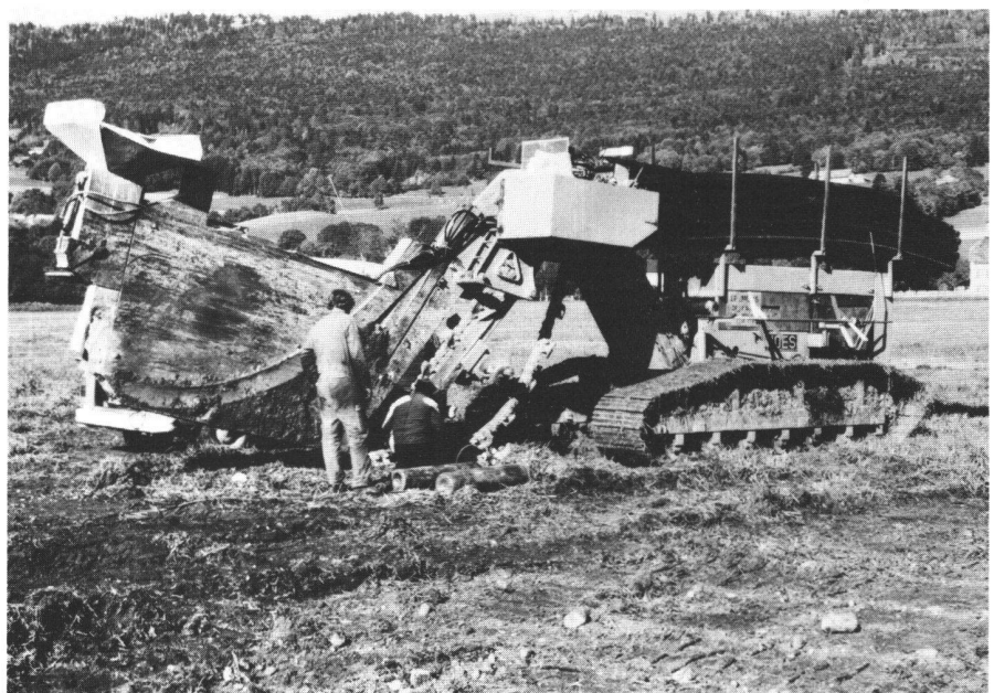
Fig. 7 Drainage 1983, draineuse, réparation de la chaîne
