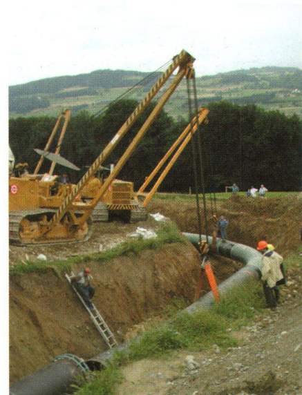
Abb. 1: Der Absenkvorgang der tonnenschweren, verschweissten Rohrleitung ist ganz besonders anspruchsvoll. Bei dieser Arbeit werden von den sogenannten Seitenbäumen die höchsten Auflagedrucke, die auf den Boden wirken, erzeugt (Foto Judith Burri).
