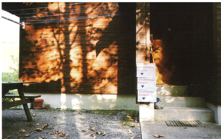
Abb. 1: Überschwemmungskoten an einem Gebäude.
