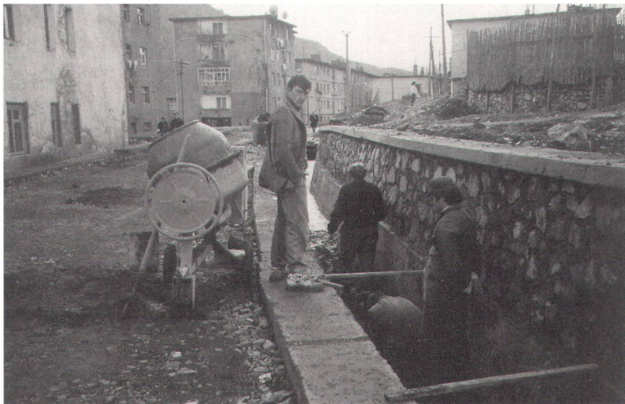
Abb. 3: Baustelle Infrastruktur-Programm: Meteorwasserkanal und Quartierstrasse.
