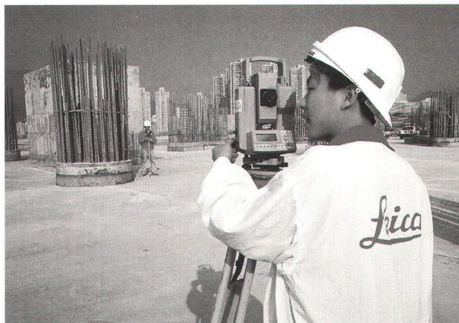
Stahlbetonpfeiler-Einmessung auf dem Tsing-Yi-Bahnhof mit Tachymeter Leica TC 1010. Auch Hochbauten bestimmen in beträchtlichem Umfang das Flughafen-Projekt. Hier auf der Insel Tsing-Yi entsteht im Moment in Mitte der Flughafen-Gesamstrecke der erste Bahnhof dieser Insel. Er soll zu ihrem Verkehrs-, Erlebnis-, Einkaufs- und Kulturzentrum werden. Leica-Instrumente sind Standard bei dem in vier Sektionen unterteilten MTRC-Vermessungsprojekt der Flughafen-Eisenbahnlinie.
