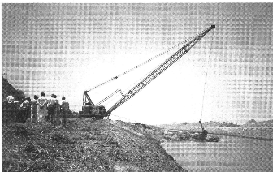
Abb. 3: Ausbaggern von Sedimenten aus Hauptzuleitern; Sindh-Pakistan, 1993. (Foto A. Mauderli.)
