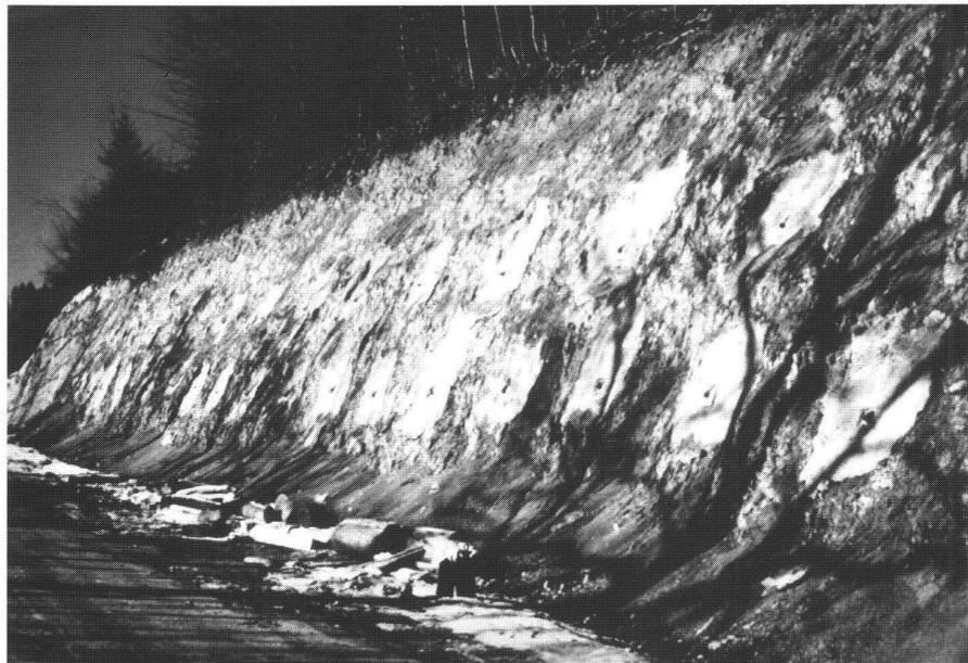
Fig 1: Stabilisation du talus par clouage de plots de gunite.
