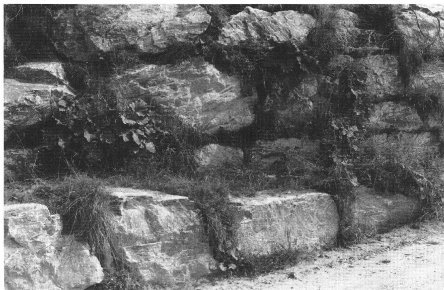
Abb. 7: Blockwürfe werden vorzu mit anstehendem Oberbodenmaterial verfüllt zur sofortigen Inbesitznahme durch die örtliche Vegetation.
