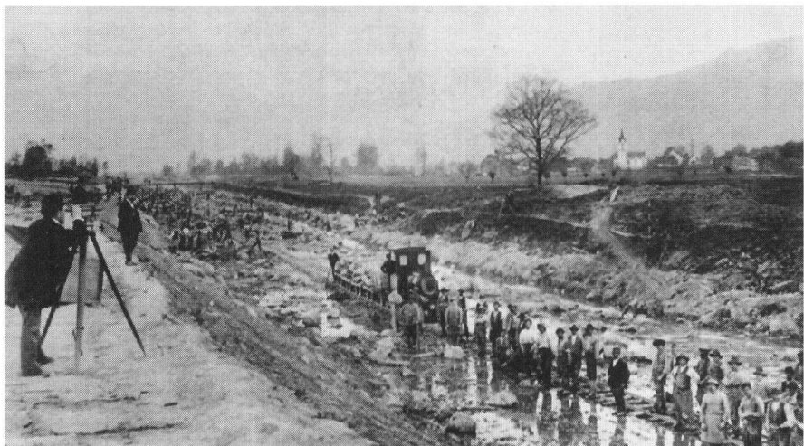
Abb. 1: Bau des Werdenberger Binnenkanals bei Salez 1882/83.
