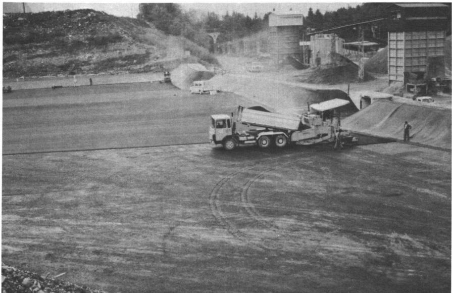
Abb. 5: Einbau der Sohlenabdichtung für eine Deponie in der Nähe von Spiez/Wimmis.
