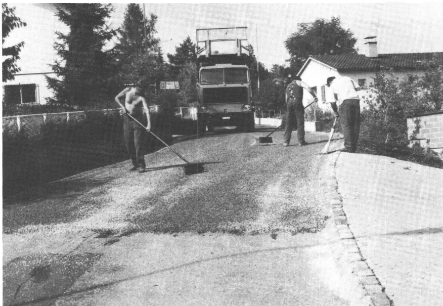
Abb. 5: Baulicher Strassenunterhalt (Foto: R. Crivelli, Bauamt Baar).
